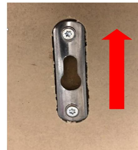
1. Das Befestigungsmaterial für die Wandfixierung hängt vom Wandaufbau ab und ist nicht Teil des Lieferumfangs. Es sollte eine adäquate, fachmännische Wandbefestigung durchgeführt werden. Mit Vollbestückung hat Xi Wall ein Gewicht von bis zu 100 kg.
