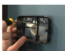
G. Bevestig de voorste afdekplaat op de achterplaat door deze op zijn plaats te schroeven.
