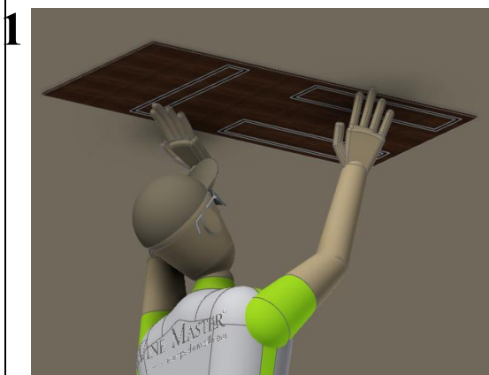
Verfolgen Sie anhand der Schablone den Standort der Klimaanlage (achten Sie darauf, dass nichts den Zugang zur Filterklappe verhindert)
