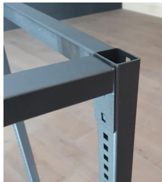
4. Querverbinder einhängen 4. Hang in cross connection
